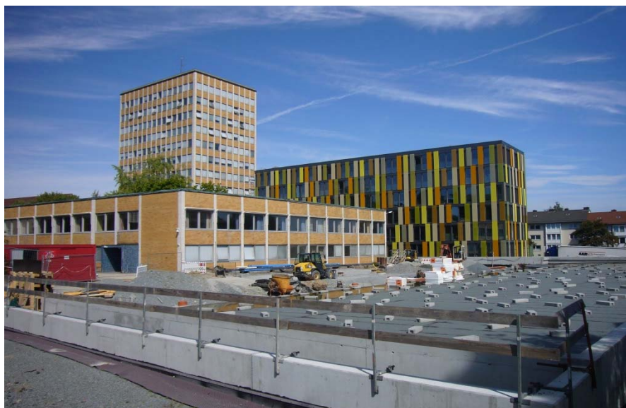
Ansicht von Südwesten mit Parkdeck im Bau (Foto: StBA)
