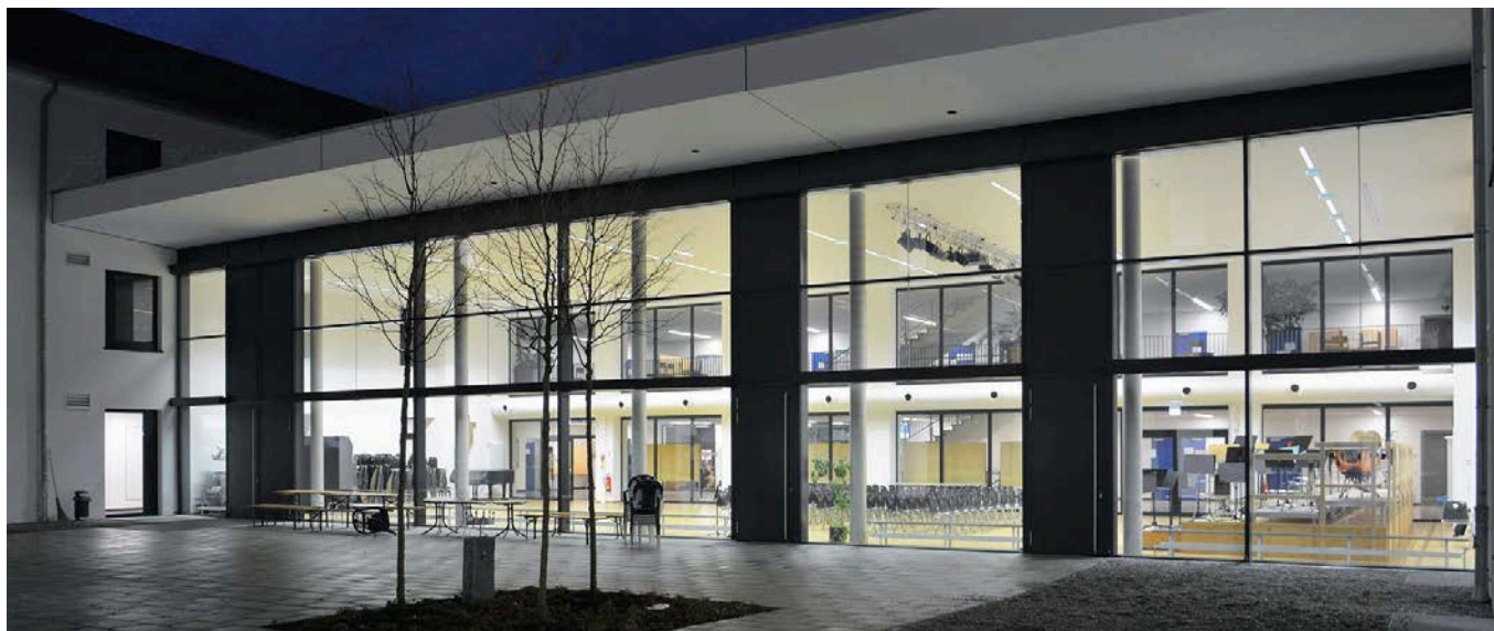
Neue Aula und Innenhof I (Foto: StBA Kempten)
