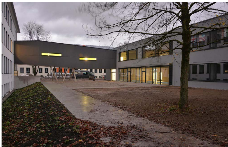
Neuer Innenhof mit Verbindungssteg (StBA Kempten)
