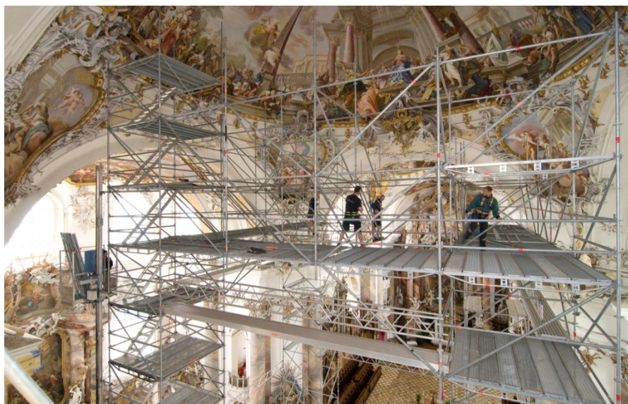
Gerüstbauer in der Vierungskuppel (Foto: H. Rupp, Kempten)
