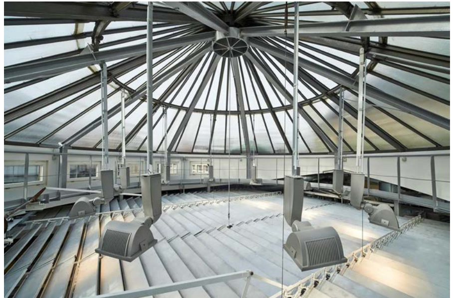
Verstärkte Oberlichtlaterne über dem Hörsaal (Foto: Anton Brandl)
