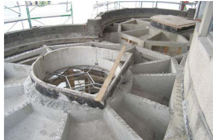
Statische Sanierung der Flachdecken und der zentralen Kuppel
