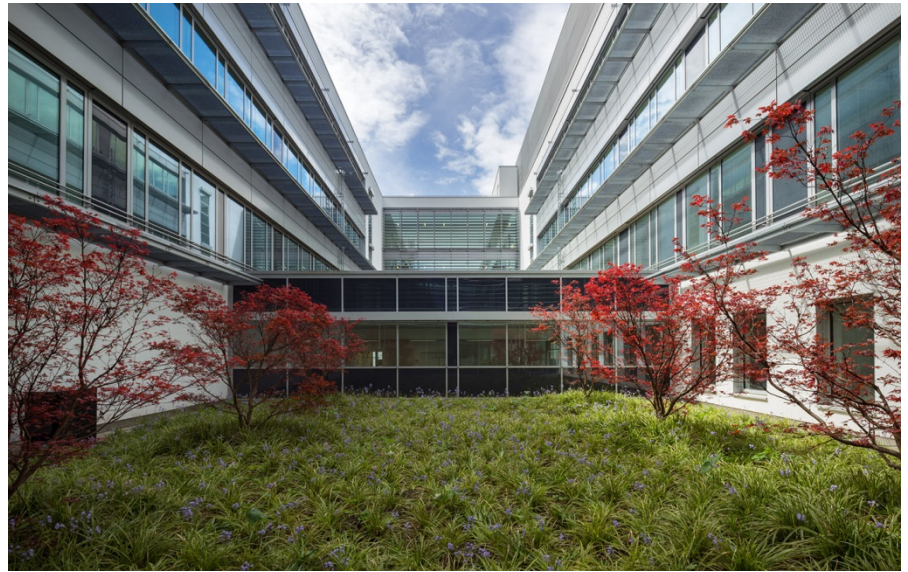
Innenhof (© Rainer Viertlböck)
