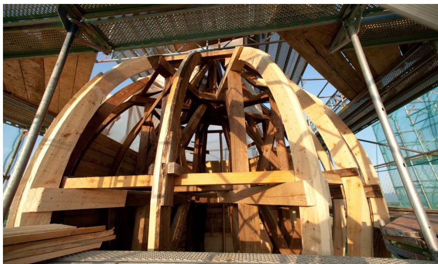
Detailaufnahme Sanierung Zwiebeltürme
