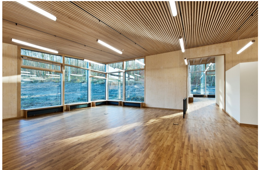
Foyer mit versetzter Buchen-Fichten-Brettstapeldecke (Foto: Katrin Heyer, Würzburg)
