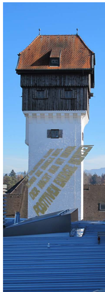
Wasserturm (Foto © StBA TS)
