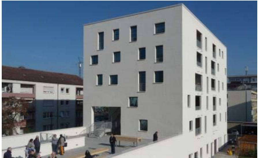
Wohngebäude mit Gemeinschaftsterrasse (Foto: Karin Sandeck) © Experimenteller Wohnungsbau
