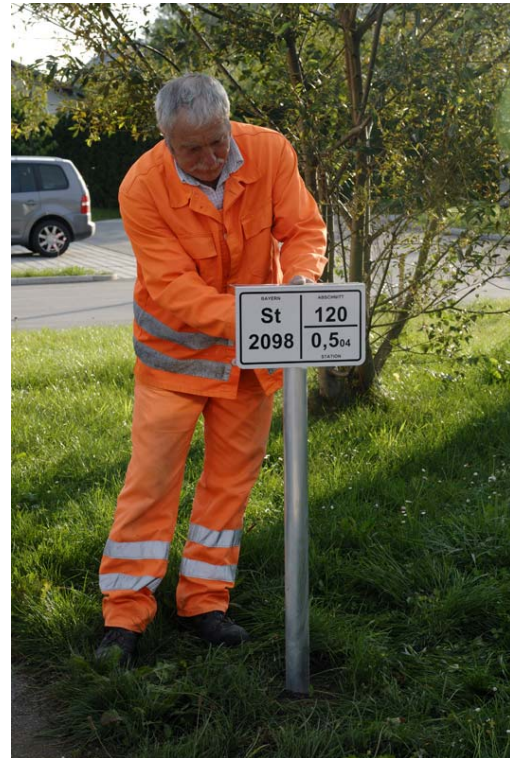
Ein Stationierungszeichen wird befestigt. © Staatsbauverwaltung
